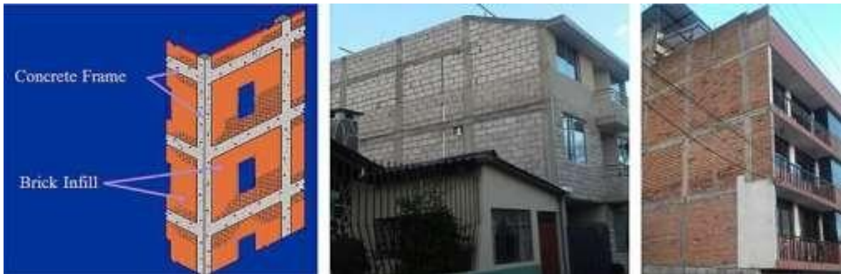
Figura 44 Tipo de sistema estructural: Pórticos de hormigón armado con mampostería confinada sin refuerzo (C3).
