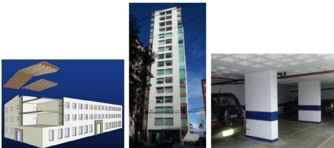
Figura 43 Tipo de sistema estructural: Pórticos de hormigón armado con muros estructurales (C2).
