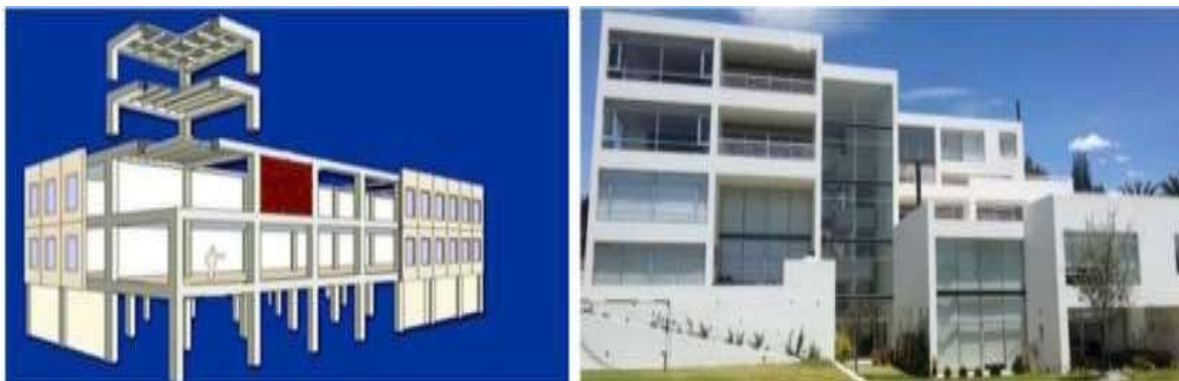
Figura 42 Tipo de sistema estructural: Pórticos de hormigón armado (C1).
