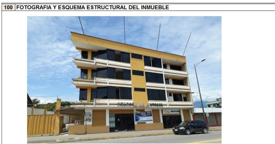
Figura 7 Fotografía Fachada Principal del Inmueble.
