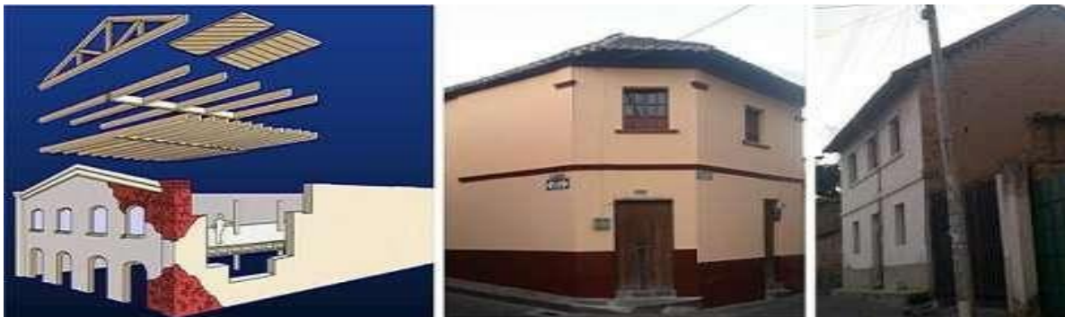
Figura 40 Tipo de sistema estructural: Mampostería sin refuerzo (URM).
